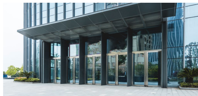
Deur- en gevelbouw
